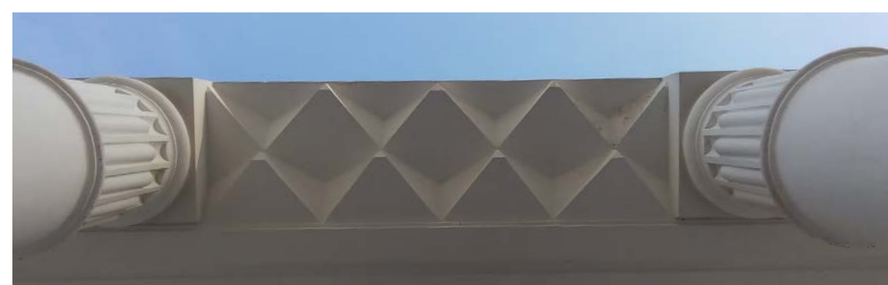
Columnas de la entrada. Fuente: L. Etxepare
