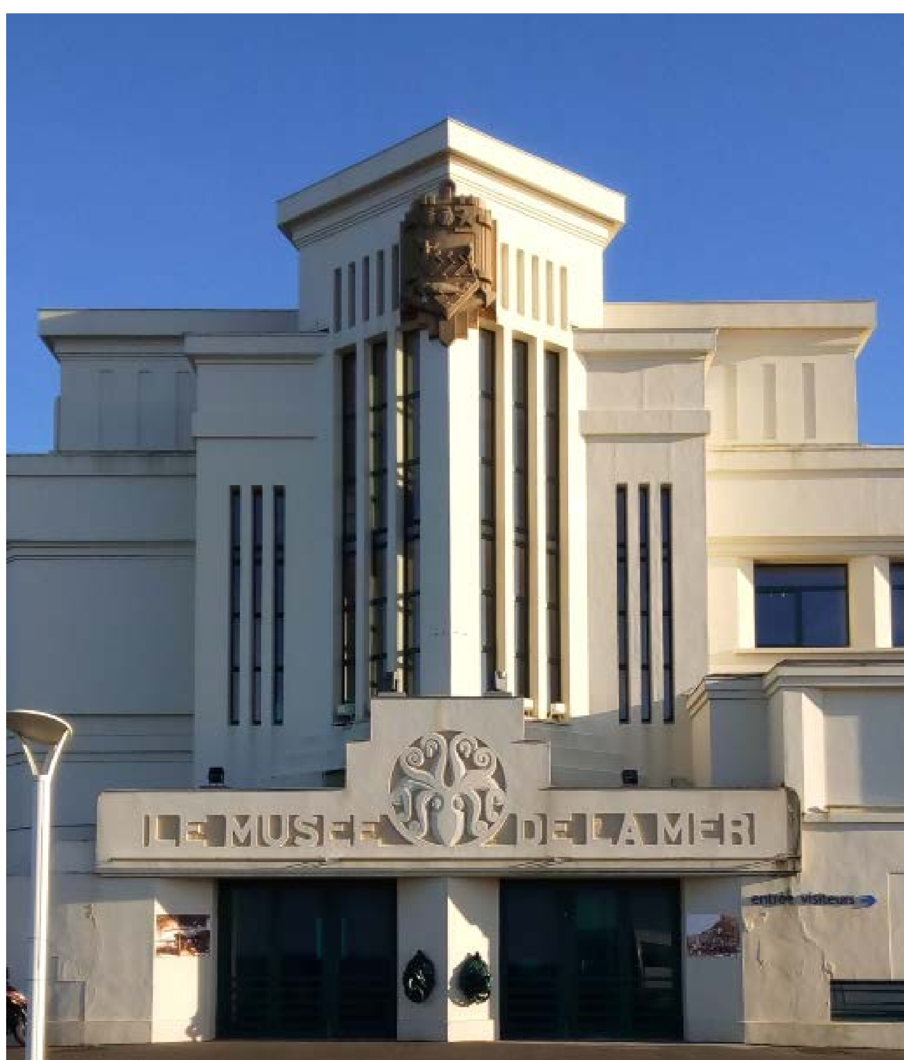
Fachada principal del museo. Fuente: L. Etxepare
