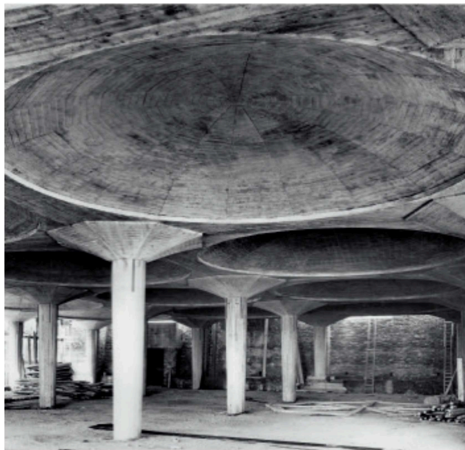
La plaza del Mariscal Foch en Argelia. 1935-1941. Estructura de hormigón armado del garaje casi acabada. Fuente: Building Beyond The Mediterranean Studying The Archives of European Businesses (1860-1970). Autor de la fotografía: Chevojon.
